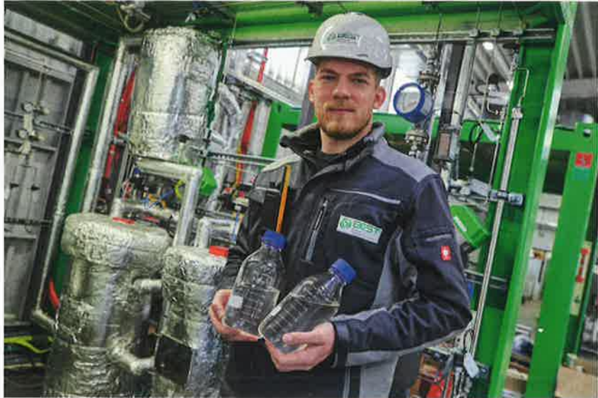
Erfolgreiche Wasserstoffproduktion aus Abwässern
