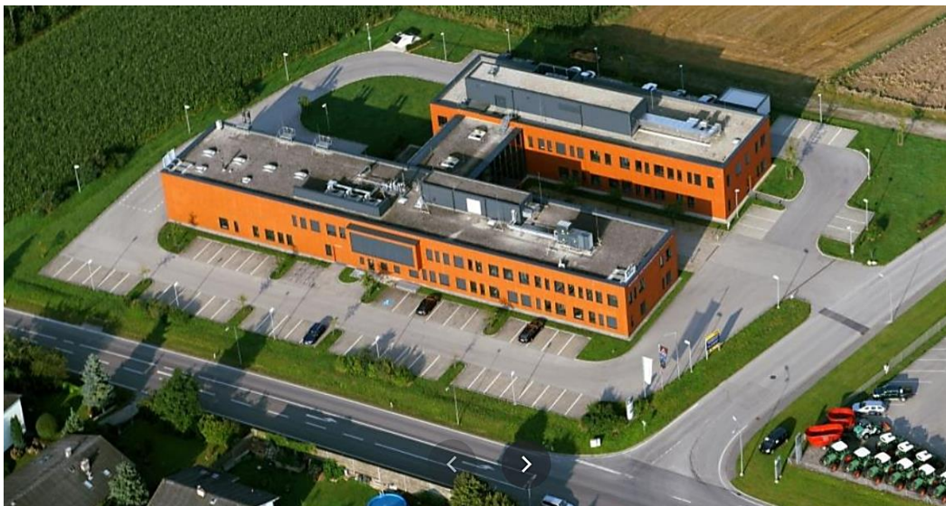
Abbildung 29: Technologie- und Forschungszentrum (TFZ) Wieselburg (Quelle: ecoplus)
